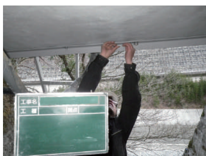
4. 水切り板設置・ボルト締め付け
