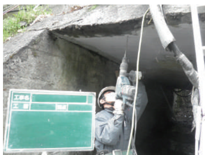
4. 水切り板設置・ボルト締め付け
