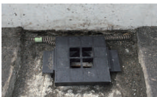
中心タイプ・舗装施工前
