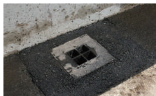
中心タイプ・舗装施工後
