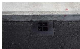
偏心タイプ・舗装施工後
