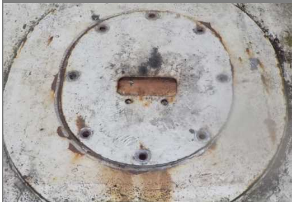
既設鋼製蓋 (改修前)
