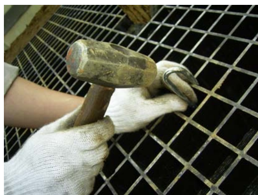
写真-4 アンカーパネルの設置状況
